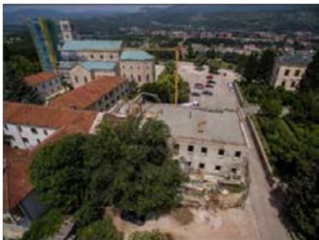
U srijedu, 22. lipnja 2016. salivena je treća armirano-betonska ploča (24 cm). U ploču je utrošeno: 110 prostornih metara betona i preko 15 tona željeza
